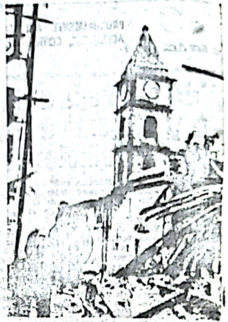
La dramática foto, revela el estado en que quedó la Iglesia del pequeño pueblo de Balvano cuyo derrumbe provocó un gran número de muertos debido a que en el momento de producirse el terremoto, el templo estaba colmado de gente.
