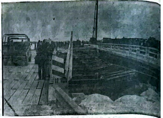
En la foto, una parte del puente construido por el ejército y Vialidad sobre el arroyo Malambo, Ruta 12, poco antes del acto inaugural.
