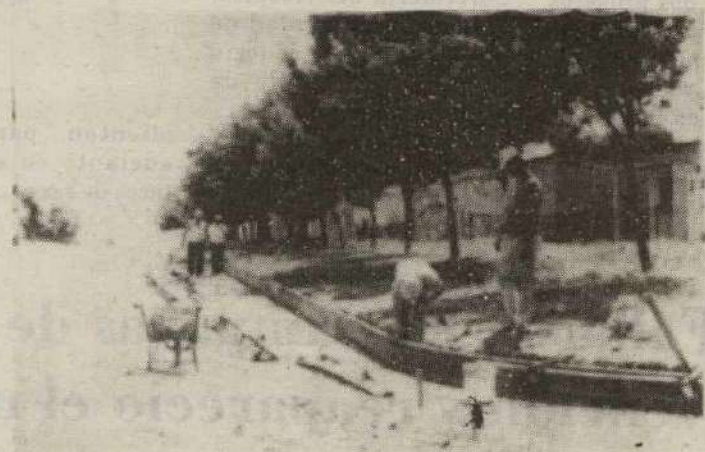
En la gráfica aparecen obreros municipales trabajando en los cordones cunetas de calle Tratado del Pilar, casi Islas Malvinas. (Atención Foto ALEMAN)
