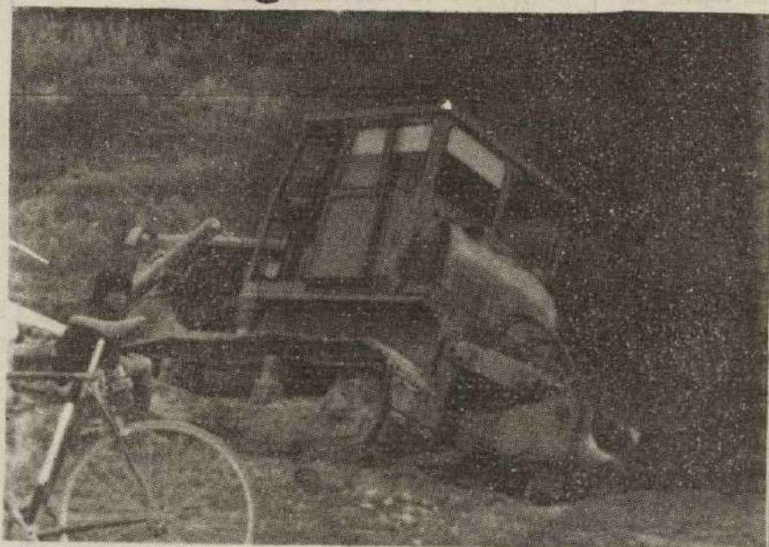
El equipo de Vialidad en la cuneta y empantamiento (Foto "Pregón")
